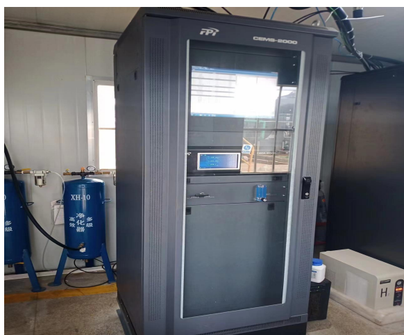
5#RTO 焚烧炉系统在线 CEMS
