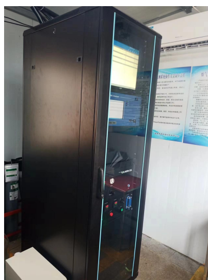
5#RTO 焚烧炉系统在线非甲烷总烃
