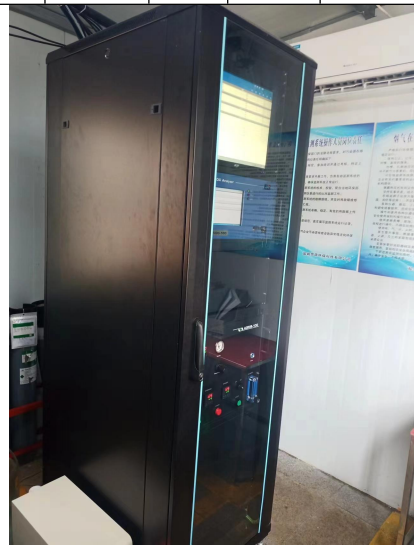
5#RTO 焚烧炉系统在线非甲烷总烃
