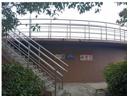
二期生化-混沉池
