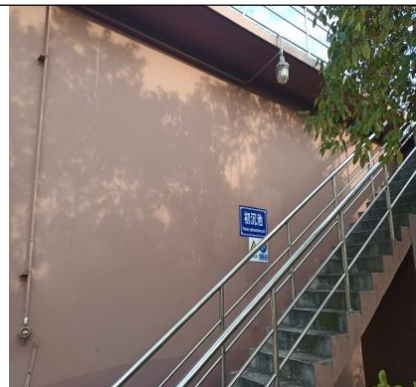
三期生化-初沉池
