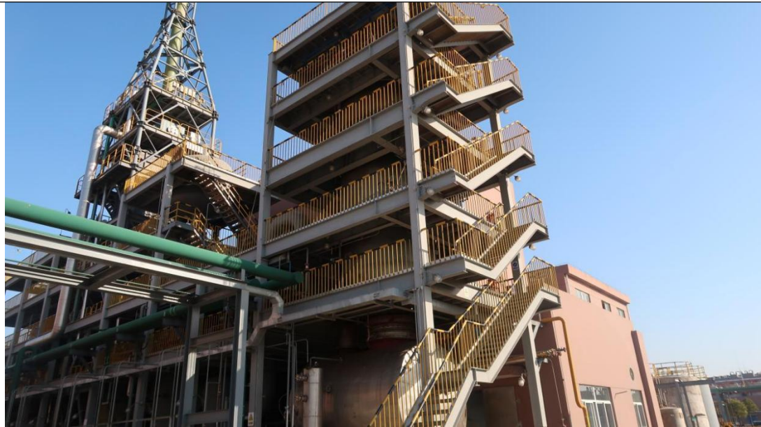
液中焚烧炉照片
