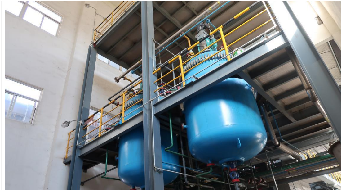
废盐焚烧炉照片
